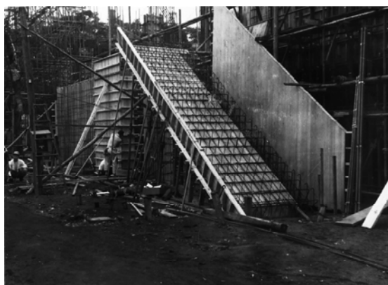
写真-8 本館の北西側階段の型枠
