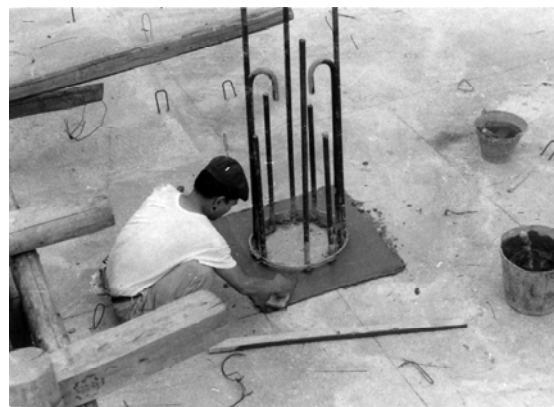
写真-13 本館丸柱足元の左官工事
