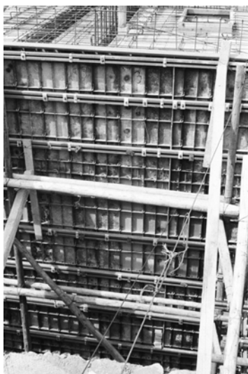
写真-10 本館地階のメタルフォーム
