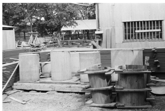
写真-6 本館丸柱の施工方法決定のための実験
