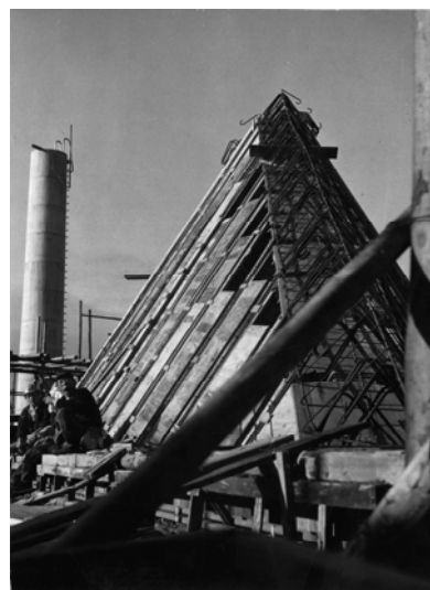
写真-11 本館大屋根の型枠
