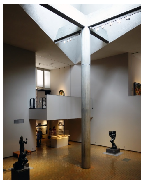
写真-1 コンクリート打放し仕上げの柱梁 (国立西洋美術館本館)
