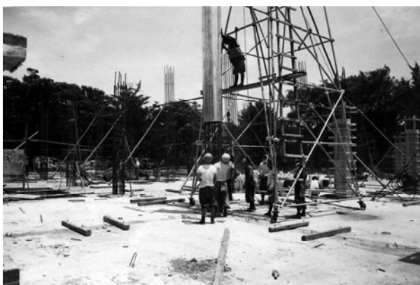
写真-12 本館丸柱の金属製円筒設置
