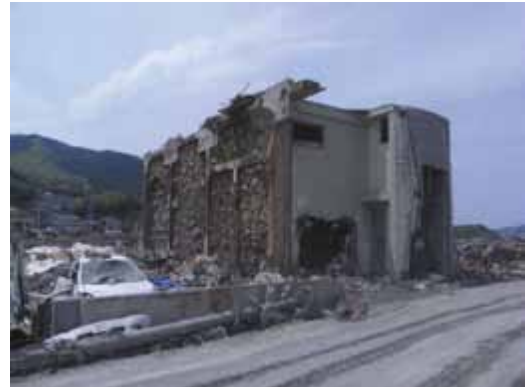
写真-5 転倒したRC造建物の例(宮城県女川町)
