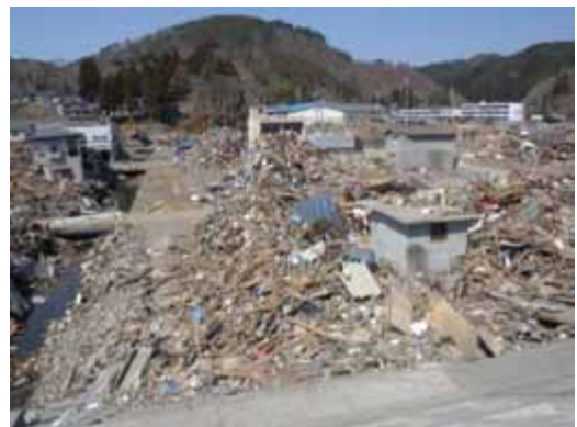
写真-1 宮古市田老地区の被災状況 (田老地区：周辺での浸水深は地盤から3.5m～4.8m程度)
