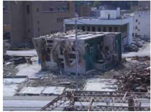
写真-4 転倒したS造建物の例(宮城県女川町)
