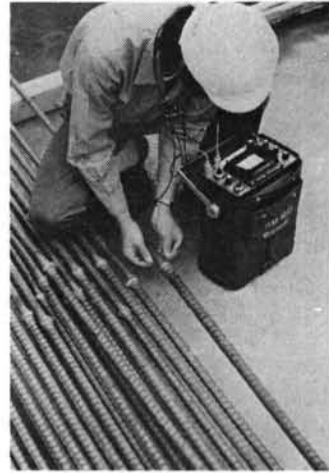
写真-1 汎用探傷器による探傷風景
