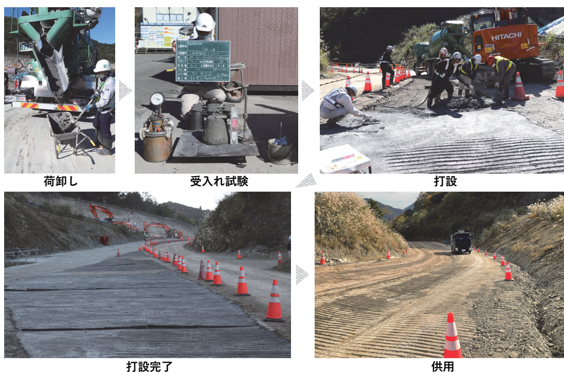
図-12 仮舗装コンクリートへの適用
